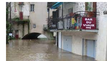
Crue de l'Aveyron de février 2021 dans le village de Laguéprie
