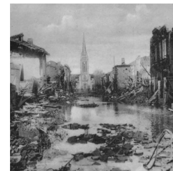
Reyniès entièrement dévasté après l'inondation du Tarn en 1930
